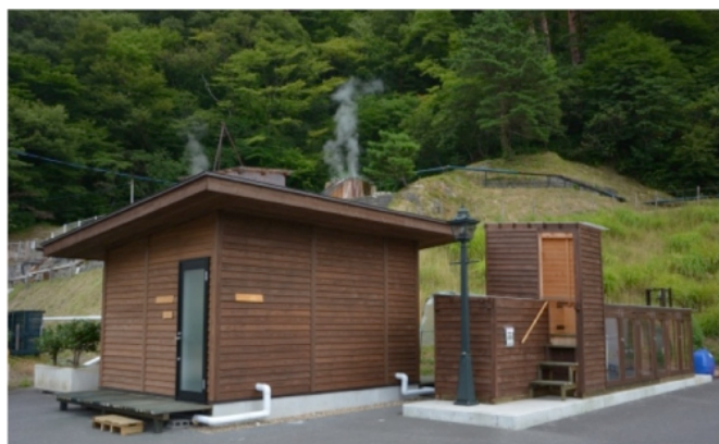
(エネカフェメタン外観)
