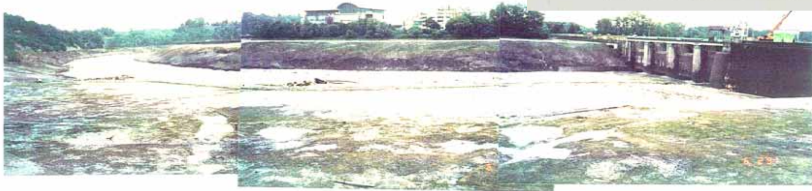
ダム上流面 (堤高 32 m, 総貯水容量 15 百万 m 3 )
