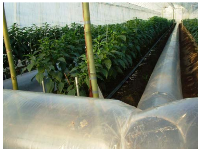
ポリダクトによる加温状況
