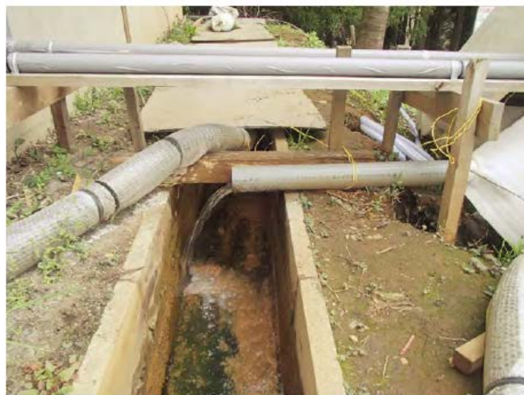
排湯槽2ton からの溢れ湯 38℃、40L/min
