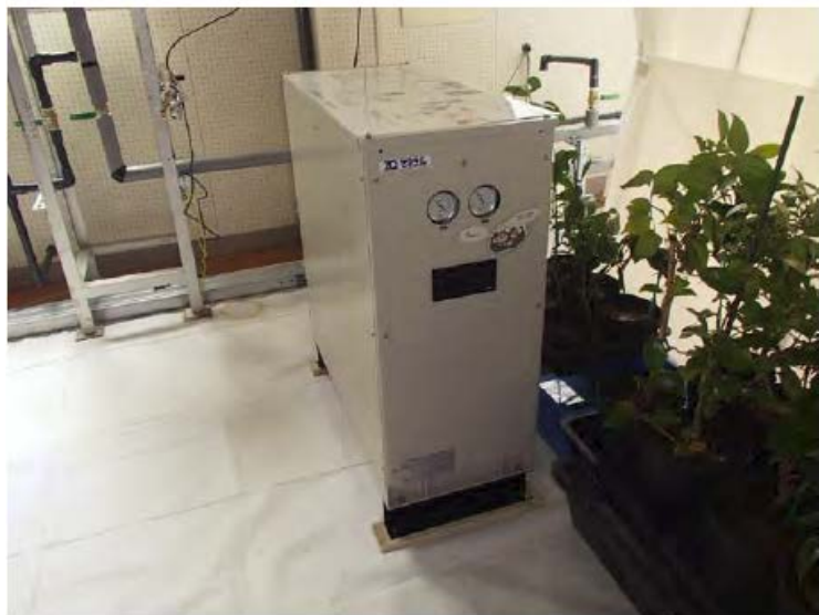
ハウス外 ヒートポンプ 室外ユニット 1.5馬力
